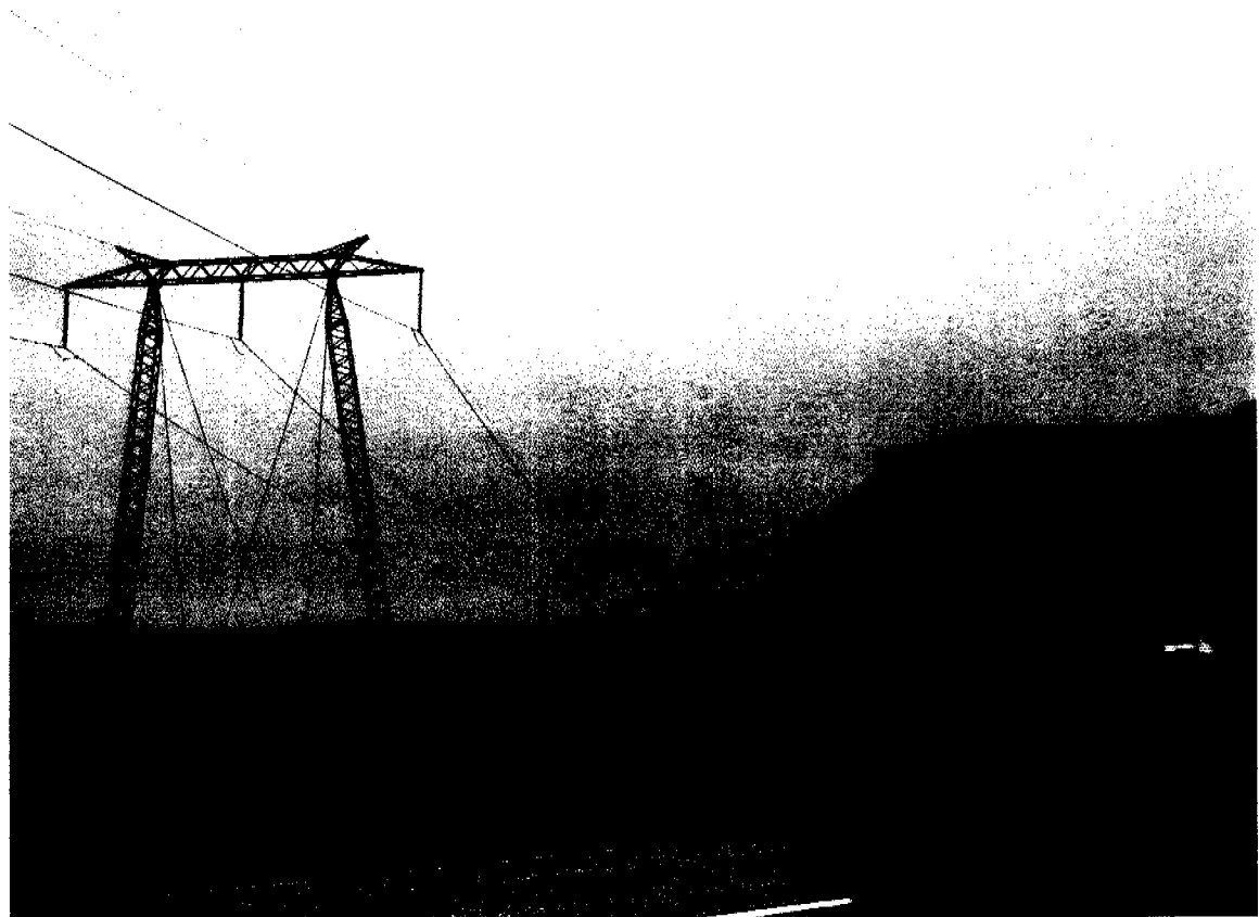
A þjóðvegi 1 á Hellisheiði. Algengasta mastraform 220 kV háspennulínu. (ljósm. G. Ólafsdóttir)
